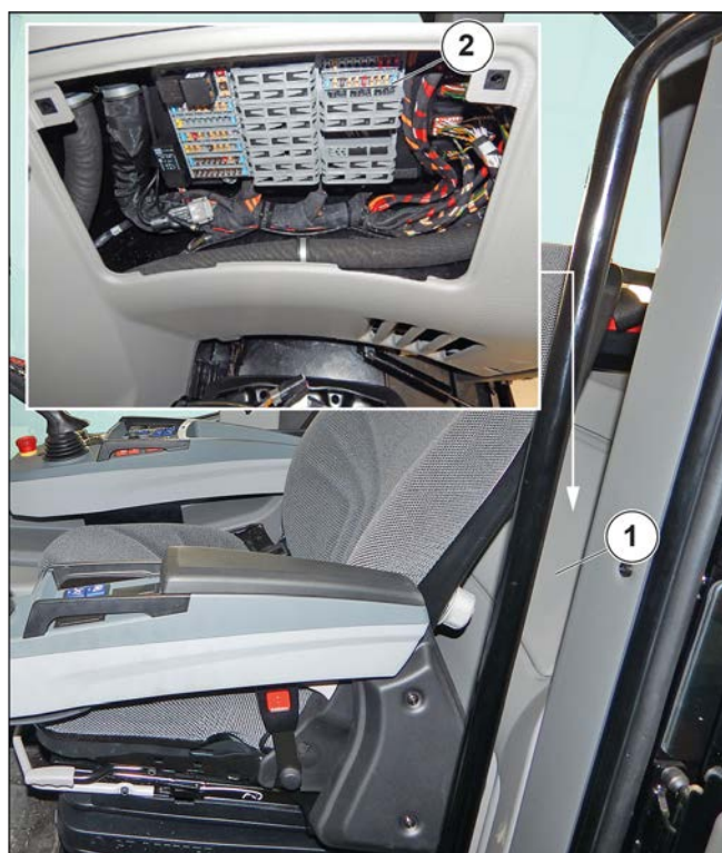
Afbeelding 214: Zekeringen en relais in cabine
