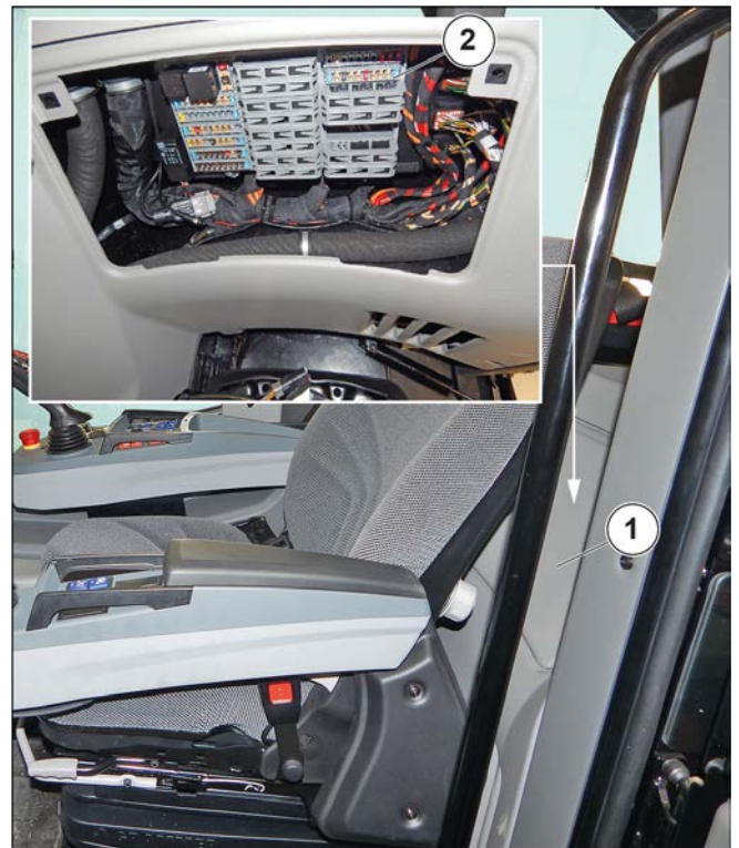
Afbeelding 214: Zekeringen en relais in cabine
